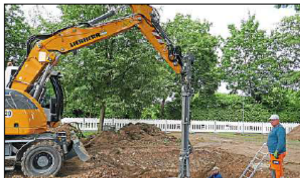
Zur Zeit wird an der Errichtung von zwölf neuen Sickerschächten bei der Grundschule gearbeitet. – Foto: Diet
