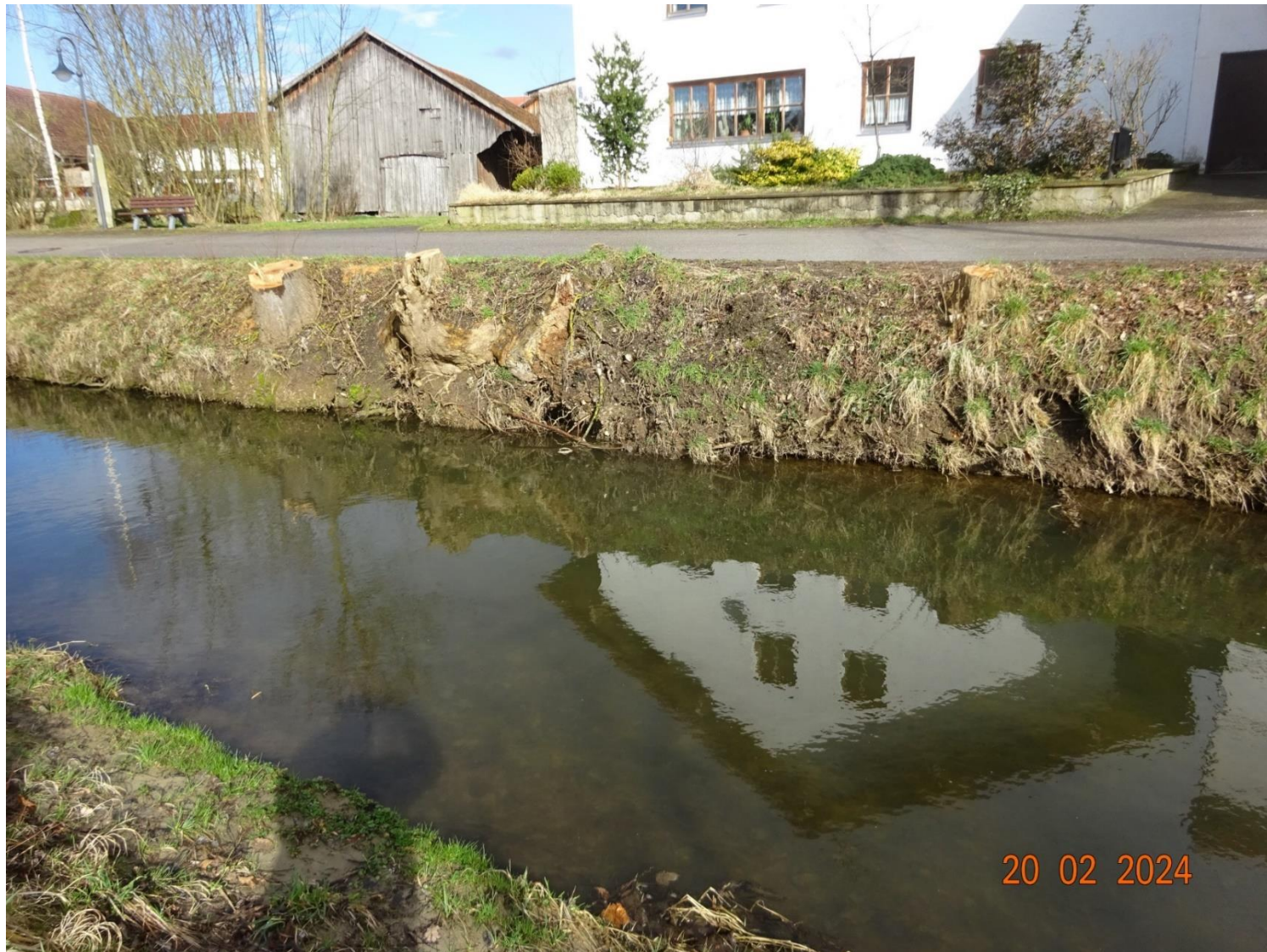
Bild vor der Baumaßnahme an der Unteren Bachstraße:
