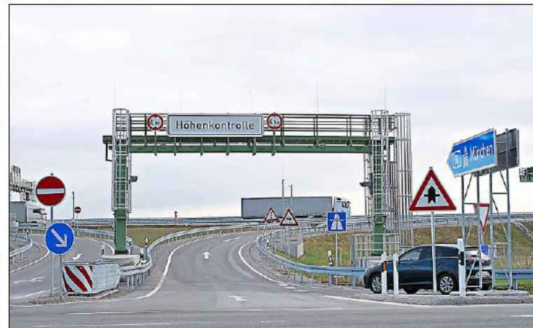
Höhenkontrolle vor der Autobahnauffahrt Kirchham Richtung München: Bereits siebenmal wollten seit seiner Eröffnung Laster in den Tuttinger Tunnel einfahren, deren Auflieger die zulässige Höhe von vier Metern überschritten. – Fotos: Georg Gertelgner
