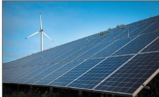
In Sachen Energiegewinnung aus Photovoltaik ist der Landkreis schon jetzt gut aufgestellt. Bei der Windkraft ist noch viel Luft nach oben. Derzeit erzeugt im Landkreis Passau nur eine Windkraftanlage Strom. Soll das Ausbauziel erreicht werden, wären bis 2040 bis zu 80 moderne Windkraftanlagen zu installieren. – F. dpa
